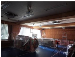
工事中の園舎内の様子
